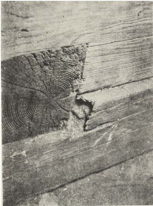
Ryc. 3. Kościół w Dębnie. Korozja drewna na przekroju podłużnym i przekrojach poprzecznych (fot. W. Galewski)
