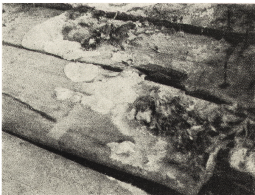
Ryc. 12. Kościół w Dębnie; grzybnia grzyba Merulius lacrymans na spodniej stronie desek podłogowych. (fot. M. Waltherowa)
