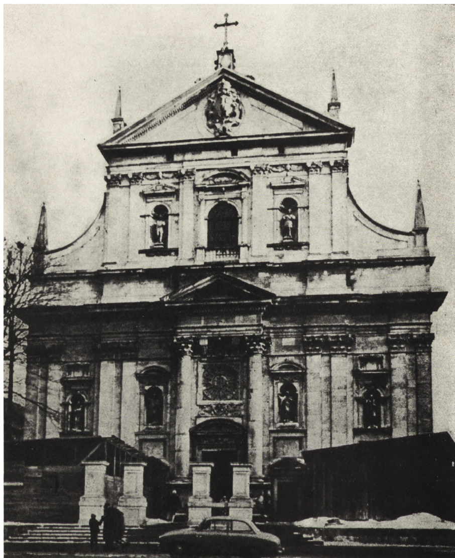
Ryc. 12. Kraków, kościół św. Piotra; stan po rozpoczęciu prac przed rekonstrukcją cokołów. (fot. E. Rachwał)
