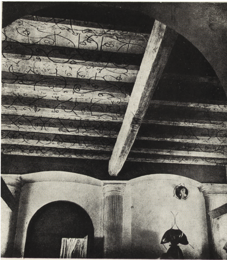
Ryc. 7. Kraków, ul. Floriańska 31, strop malowany z XVIII w., odkryty i restaurowany w 1960 r. (fot. W. Nowak)
