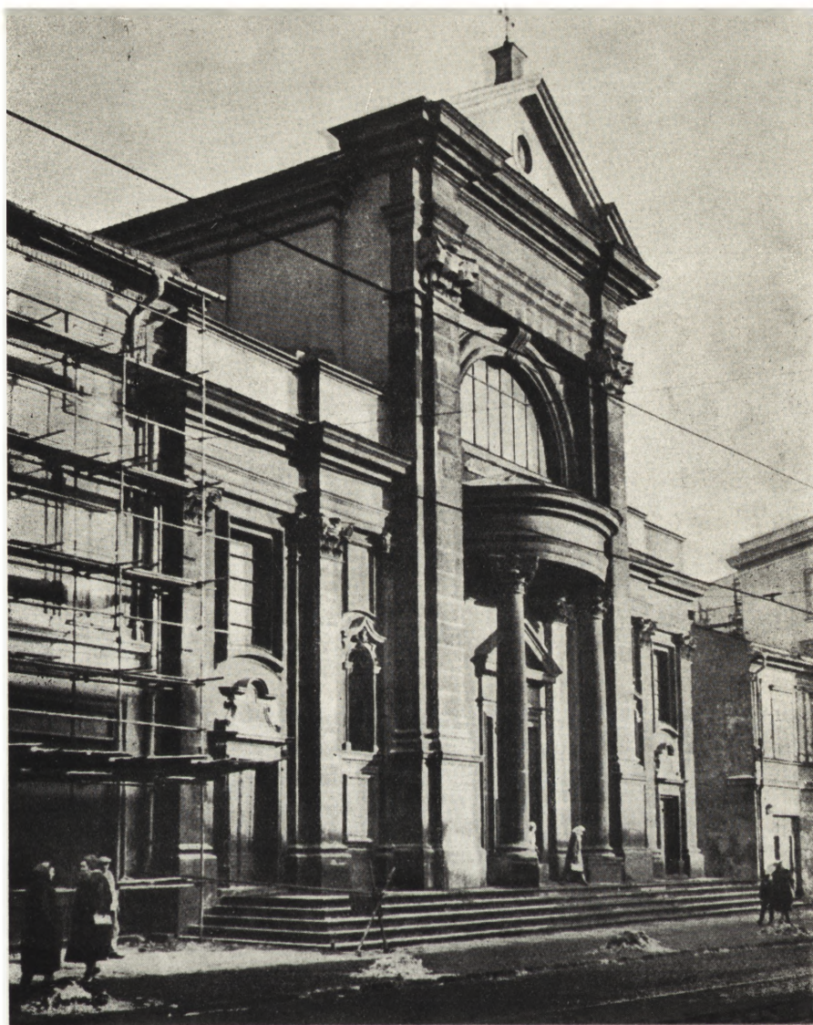
Ryc. 11. Kraków, kościół oo. Misjonarzy po remoncie i przebudowie ścian bocznych i szczytu. (fot. E. Rachwał)
