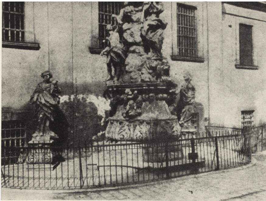
Ryc. 1. Pomnik wzniesiony przed wilgotną ścianą hamuje dostęp wiatru i słońca, powodując lokalne wznoszenie się wilgoci na wyższy poziom („Zement und Beton” 9, 1957)
