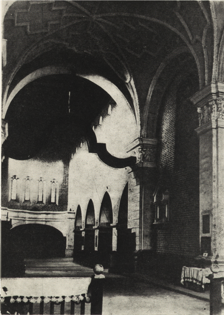
Ryc. 3. Sandomierz. Kościół św. Jakuba, wnętrze prezbiterium. Po pracach konserwatorskich w 1909 roku odsłonięte ceglane lico muru z pierwotną pisciną. Pozostawione późnorennesansowe sklepienie i barokowa belka tęczkowa (fot. IS PAN — Warszawa)
