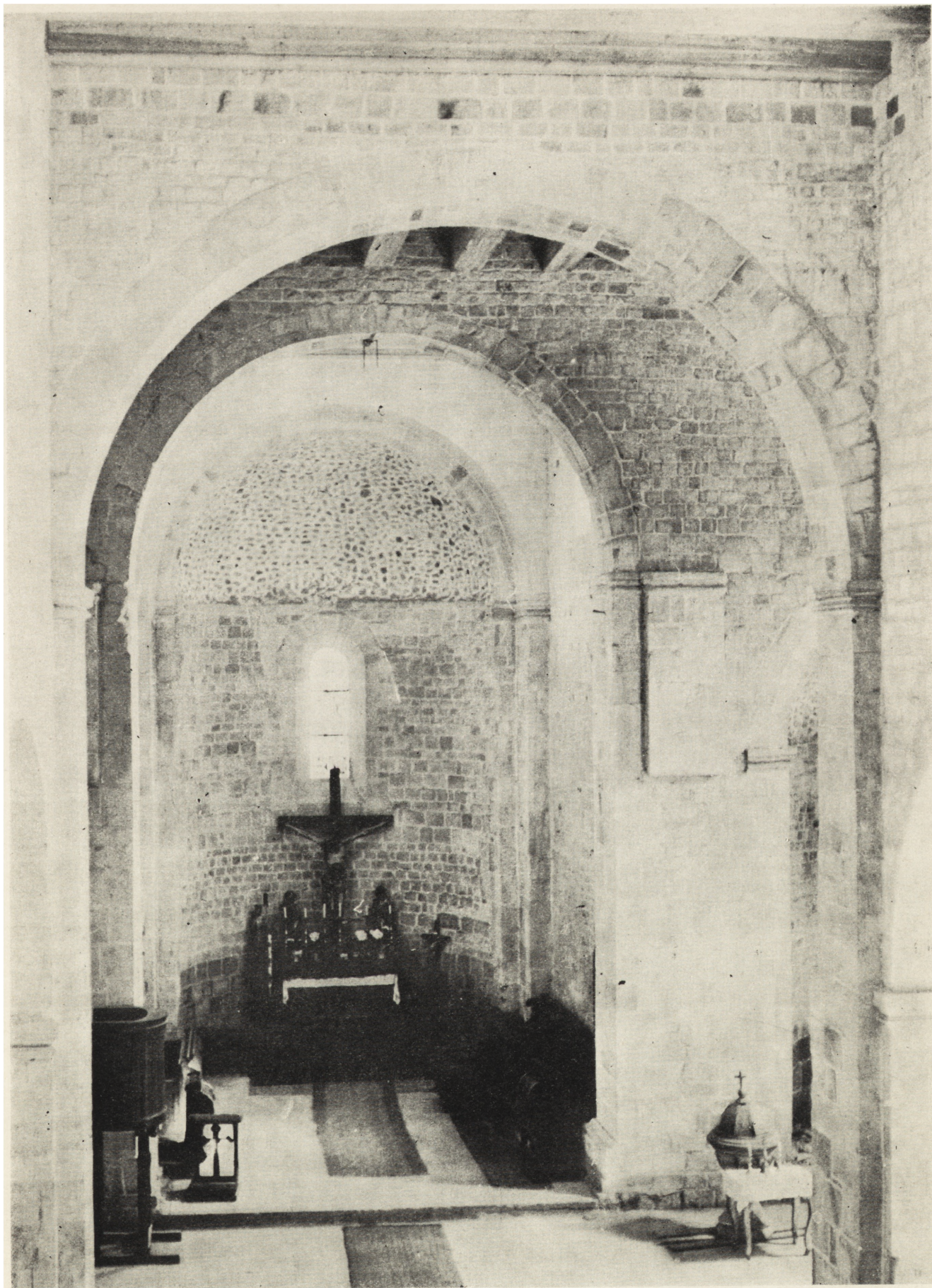
Ryc. 9. Kruszwica. Kolegiata, widok wnętrza. Przywrócenie autentycznego lica kamieniarki przez usunięcie przemurowań i tynków dziewiętnastowiecznej restauracji (fot. Z. Świechowski)
