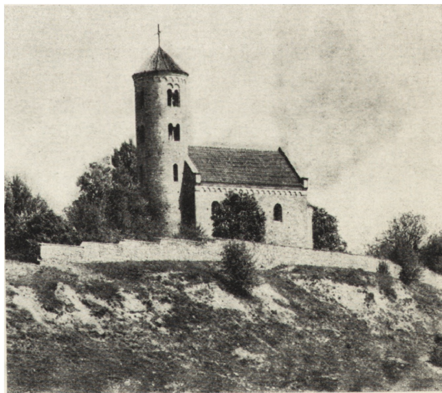
Ryc. 5. Inowłódz. Kościół św. Idziego, widok zewnętrzny — stan po rekonstrukcji
