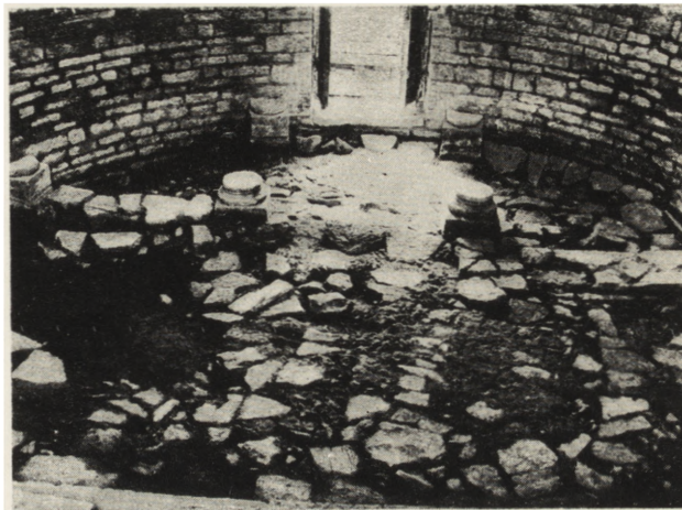
Ryc. 12. Cieszyn. Rotunda zamkowa, wewnątrz z widokiem na reliktury empory zachodniej — stan z 1942 r. (fot. Zakład Architektury Polskiej Pol. Warsz.)
