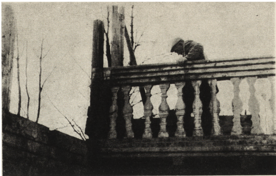
Ryc. 4. Rosolin, cerkiew, rozbiórka balustrady chóru
