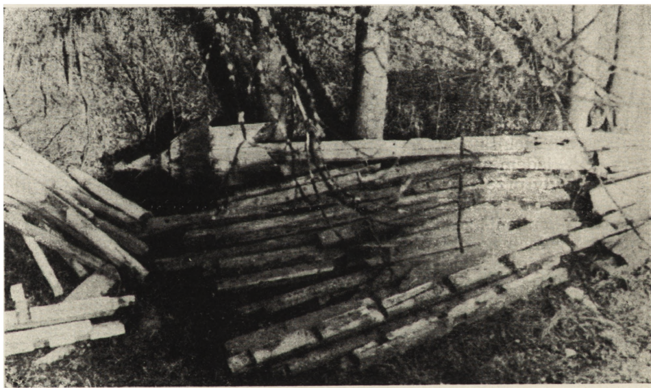
Ryc. 5. Rosolin, cerkiew, część więźby dachu po rozbiórce
