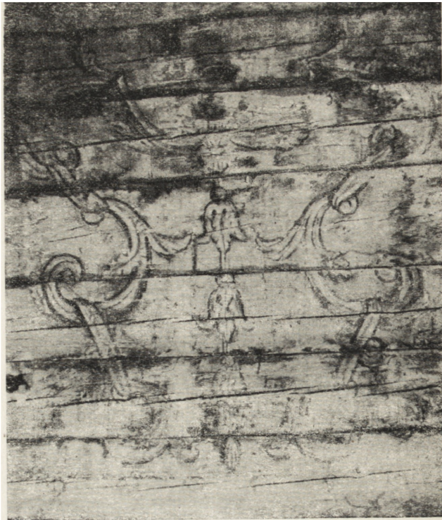
Ryc. 17. Sanok, cerkiew rosolińska, ściana południowa prezbiterium, stan po rekonstrukcji
