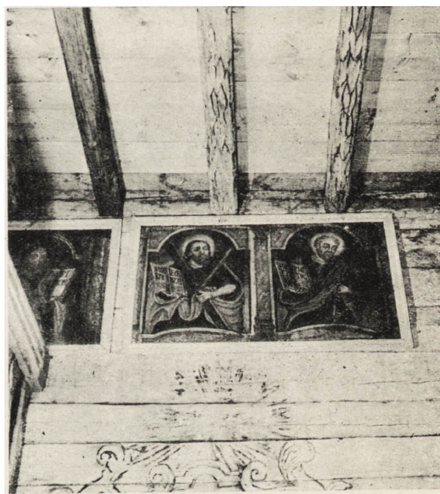
Ryc. 14. Sanok, cerkiew rosolińska, fragment nawy, ściana północna po rekonstrukcji i konserwacji
