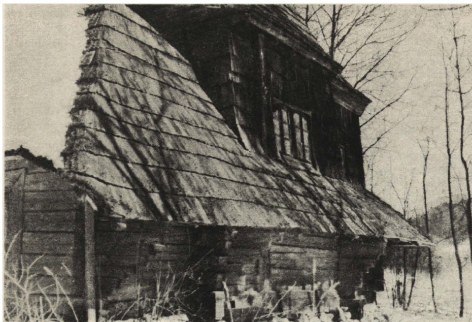
Ryc. 1. Rosolin, cerkiew przed rozbiórką
