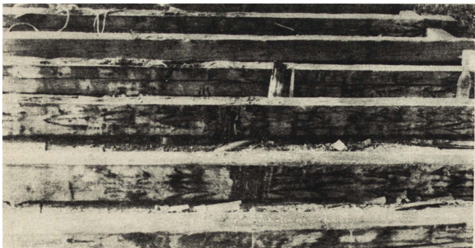
Ryc. 3. Rosolin, cerkiew, strop w czasie rozbiórki
