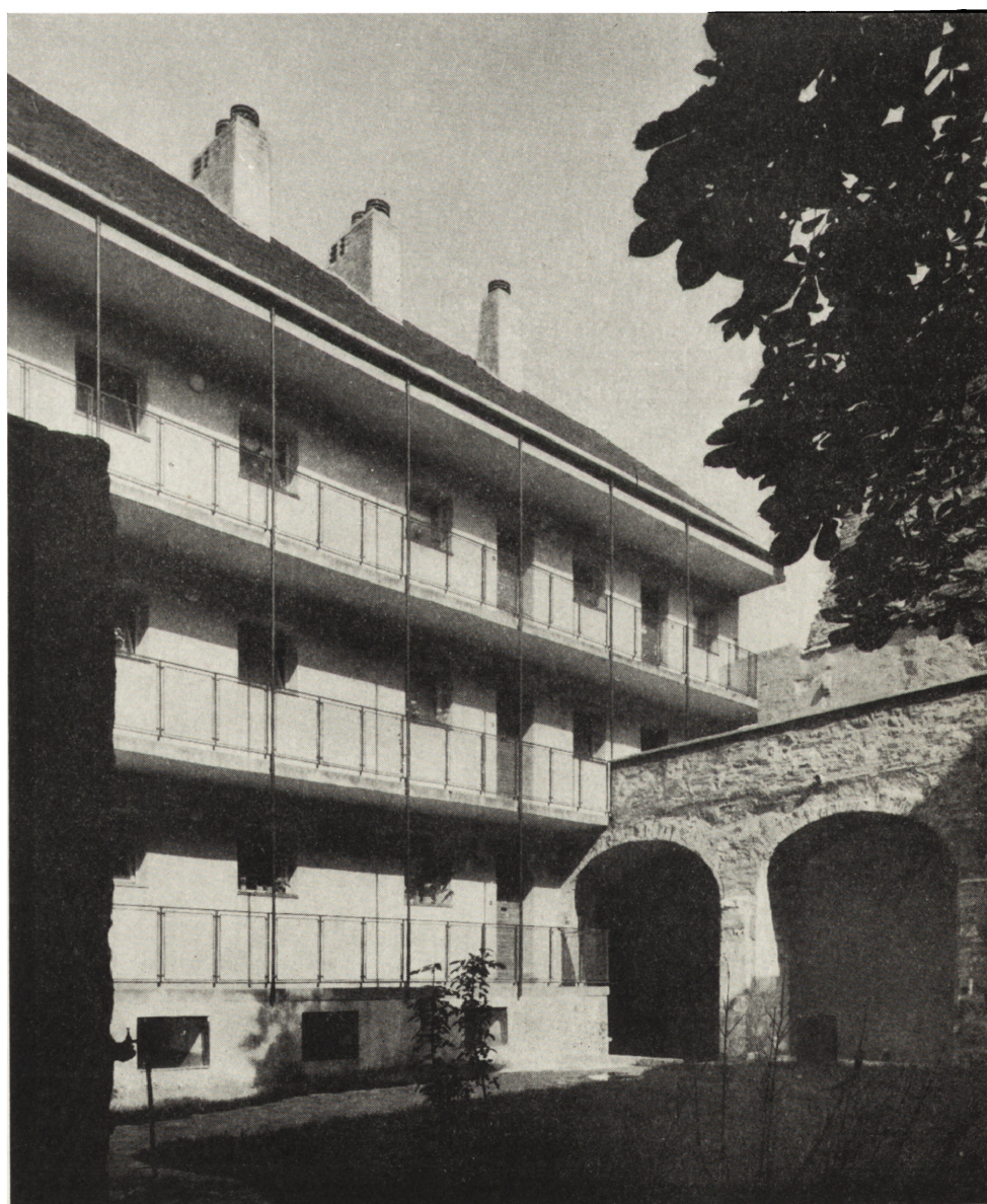
Il. 29. Dom mieszkalny przy ul. Uri 32 na twierdzy w Budzie, odbudowany przy zastosowaniu motywów współczesnych w zestawieniu z autentycznymi partiami zabytkowymi. Elewacja od dziedzińca. (Proj. Z. Farkasdy)
