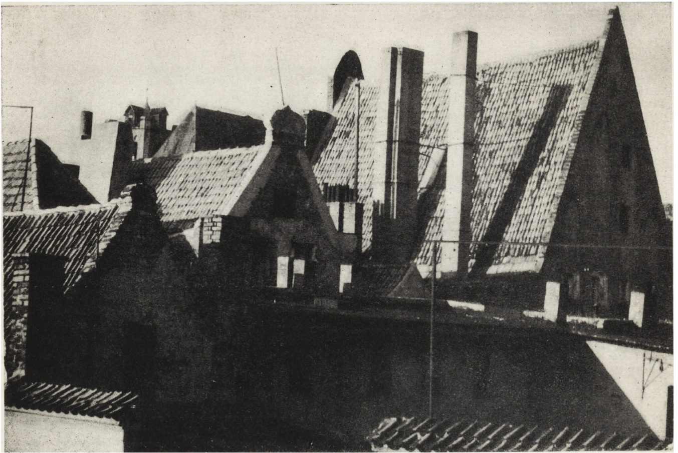
26. Toruń. Szczyty elewacji tylnych zabudowy ul. Kopernika, widok od wnętrza bloku (fot. Janina Gardzielewska)
