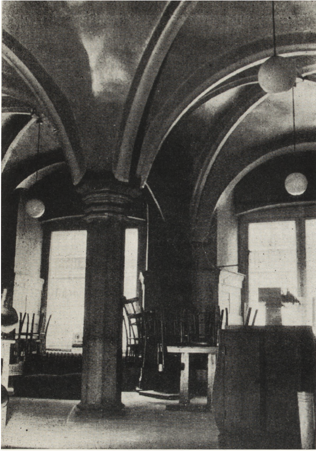
13. Toruń. Dom przy ul. Szczytnej 2, wnętrze sklepionej sali w przyziemiu (fot. MKZ Toruń)
