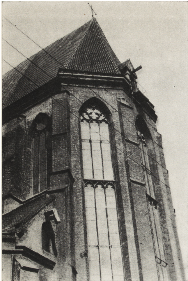
24. Wrocław. Kościół św. Elżbiety. W dachu nawy głównej widoczny otwór do wciągania ładunku i belka kierująca linę, podobne urządzenie nad niższą nawą boczną — stan z 1963 r. (fot. A. Saladziak)
