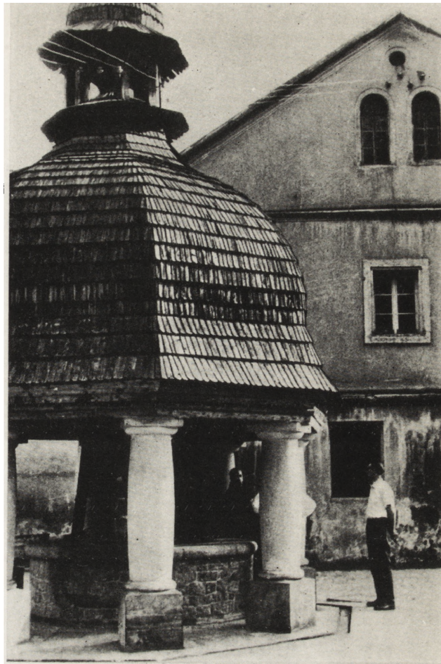
29. Czerna, pow. Kraków. Klasztor oo. karmelitów bosych. Zabytkowa studnia (posiada niestety wyciąg nowoczesny) — stan z 1963 r. (fot. A. Saładziak)
