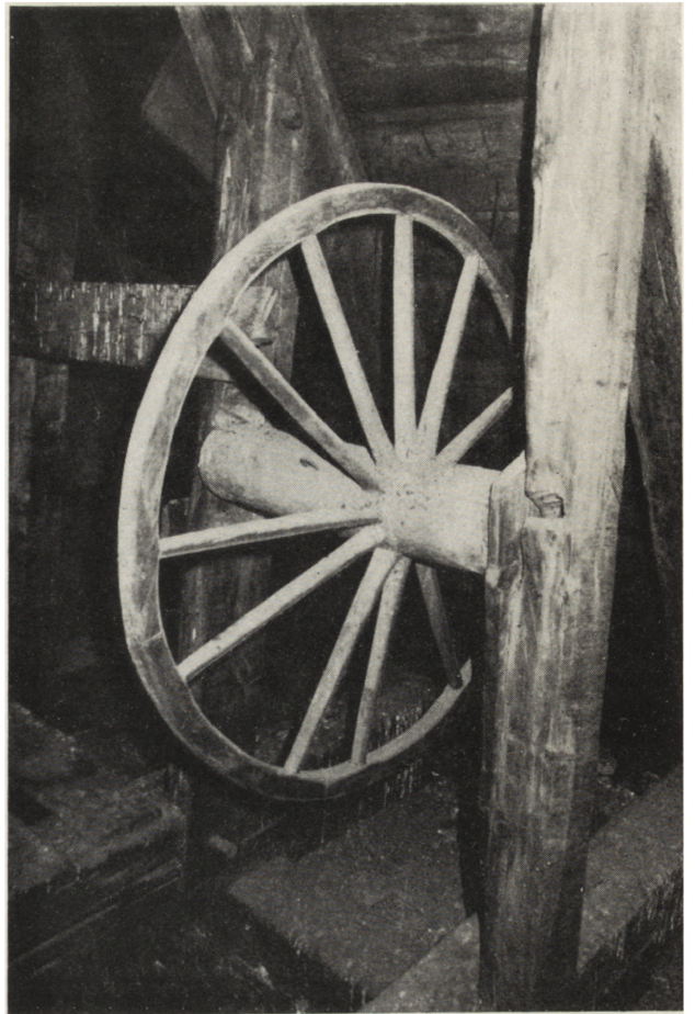
11. Kraków. Kościół Mariacki. Kołowrót z wałem poziomym i kołem, stan z 1964 r. (fot. K. Wyżga)
