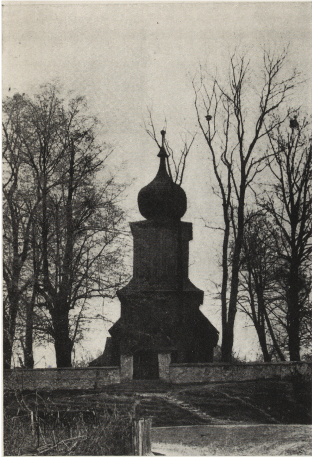
30. Ryczów, pow. Wadowice. Kościół drewniany z XVI w. — stan z 1953 r. (fot. T. Chrzanowski)
