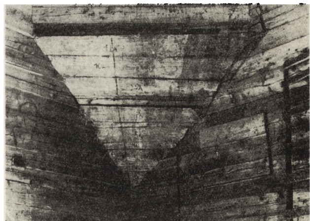
11. Pendentyw zachodni po ponownym zmontowaniu — widoczne zabezpieczenie lica malowidła przez za- klejenie warstwą ochronną
