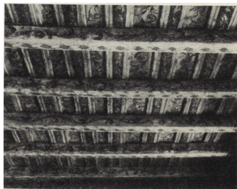
17. Oporów (pow. Kutno). Zamek. Odsłonięty podczas prac konserwatorskich strop polichromowany z XVII w. w komnacie I piętra (fot. Z. Ciekliński)
