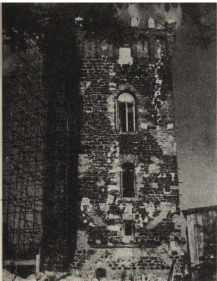
4. Łowicz. Tzw. wieża Klickiego. Widok ogólny, stan z 1962 r. po konserwacji (fot. H. Pracuta)
