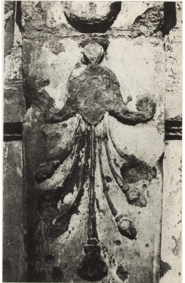
5. Gdańsk. Fragment portalu kamienicy przy ul. św. Jana 70/71. Daleko posunięty rozkład plastycznych elementów dekoracyjnych (fot. Lech Krzyżanowski)
