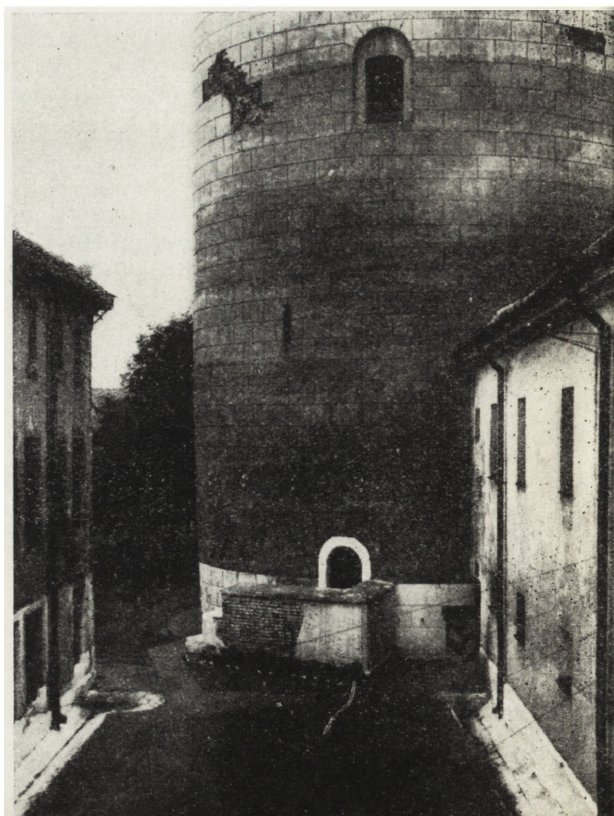
2. Lublin, donjon du château, état de 1920, vue du système d'évacuation des eaux atmosphériques
