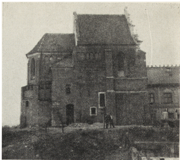
13. Lublin, zamek, roboty przy rozbijaniu fundamentów południowego skrzydła w bezpośrednim sąsiedztwie kaplicy (fot. M. Samborski)
