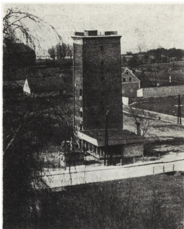
11. Frombork, „wieża wodociągowa”, stan po konserwacji
