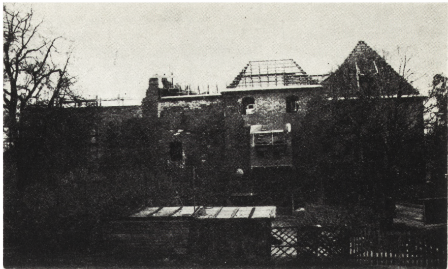
1. Kętrzyn, zamek krzyżacki, widok od zachodu, stan w trakcie prac konserwatorskich
