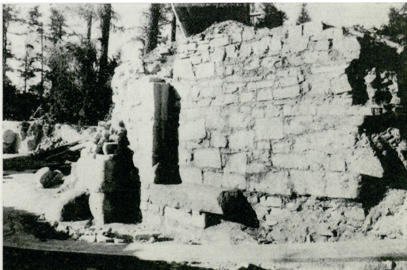
8. Lanckorona, ruiny zamku, elementy bramy odsłonięte w r. 1966 (fot. M. Kornecki)
