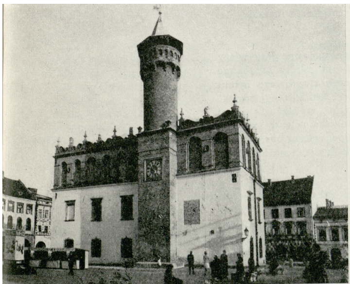
3. Tarnów, Ratusz, stan po zakończeniu robót, 1968 r., (fot. M. Kornecki)
