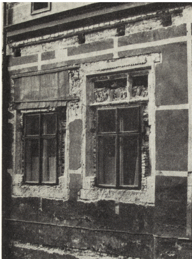
1. Kraków, ul. Kanonicza 15, siatka odkrywek pasowych (fot. J. Doraczek)
