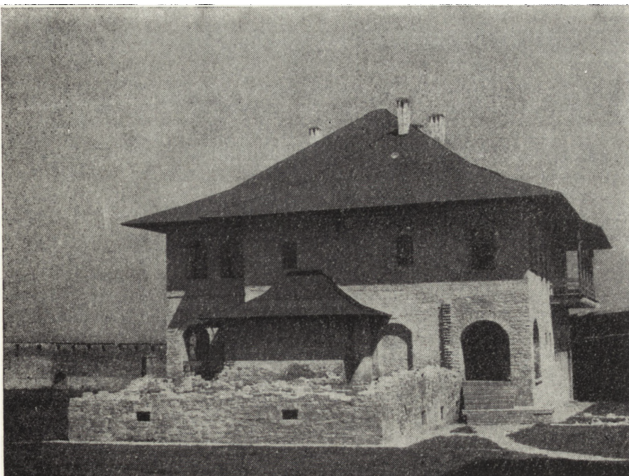
4. Jassy, Mołdawia, monaster Galata, pałac księżęcy z XVI w., stan po rekonstrukcji — pierwotne jedynie piwnice i fragmenty przyziemia (fot. R. Brykowski)
