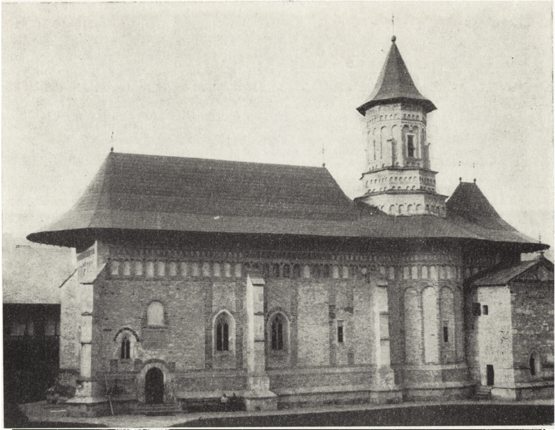
3. Neamt, Mołdawia, monaster z XV w., stan po pracach konserwatorsko-rekonstrukcyjnych obejmujących m.in. likwidację szczytu i zmianę dachu — por. „Ochrona Zabytków” 1958, nr. 3—4, il. 245 (fot. R. Brykowski)
