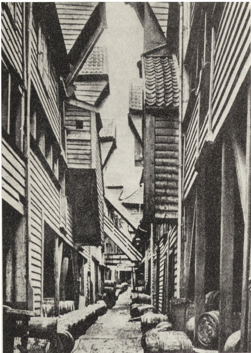
5. Bergen, wielotraktowa, głęboka zabudowa spichlerzy na nabrzeżu portowym Bryggen
