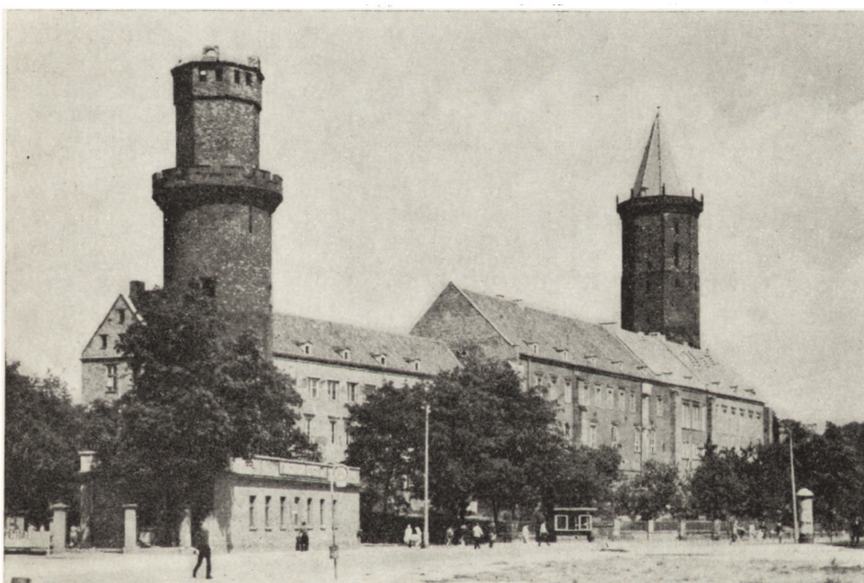
3. Legnica, zamek, skrzydło pd. w trakcie odbudowy (fot. J. Milka)
