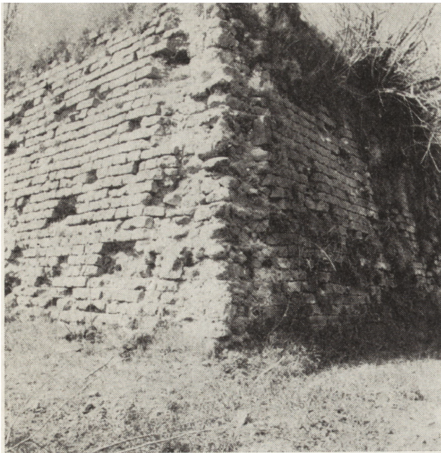
9. Kapua. Całkowicie zniszczony (pozbawiony bloków trawertynowych) narożnik czołowy rawelinu (fot. W. Łysiak)
