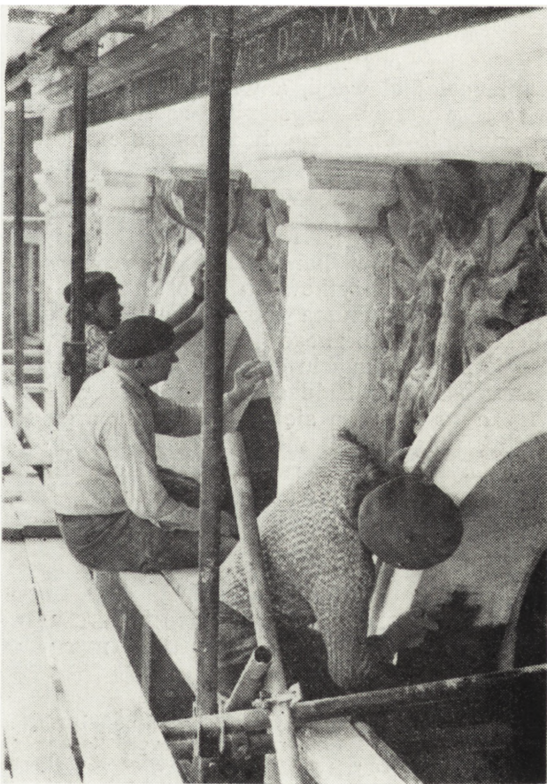
4. Poznań; czyszczenie detali architektonicznych
