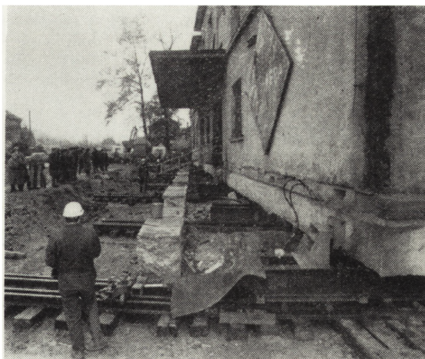
14. Magazyn chmielu w Ústíku podczas operacji przesuwania
