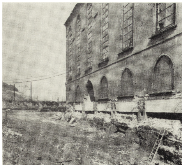
8. Obwodowy wzmacniający pas żelbetowy (fot. A. Vlach)
