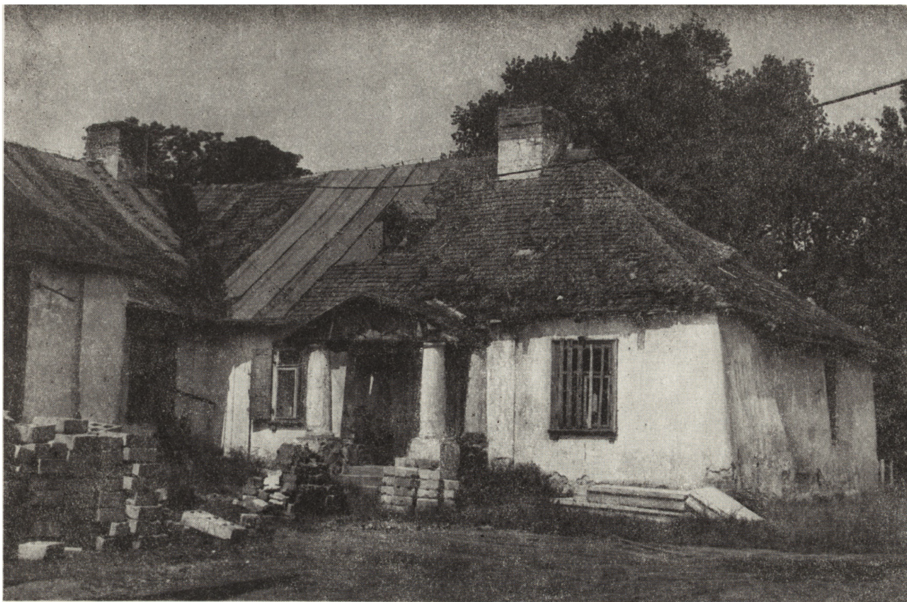
3. Niemce, pow. Lubartów. Dawny dwór, skrzydło zachodnie, stan z 1973 r. (fot. R. Brykowski) 3. Niemce, Lubartów district. The former manor house; western wing as it was in 1973
