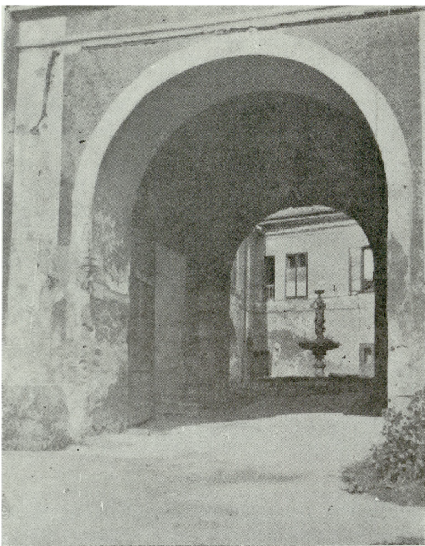
5. Zamek Blansko, brama wjazdowa, stan przed rekonstrukcją (fot. L. Lacina)
