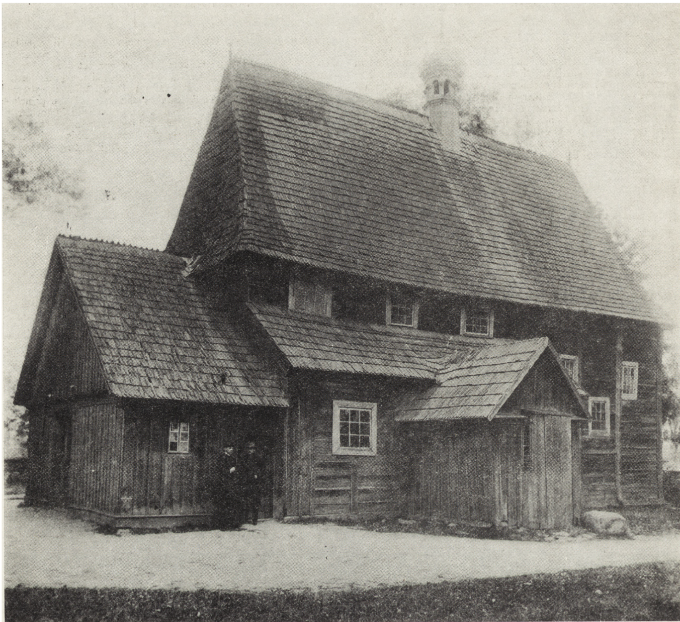
1. Białynin, nie istniejący kościół parafialny, widok od południowego zachodu (fot. K. Stefański, 1907 (?); d. archiwum TOnZP, obecnie zb. IS PAN)
