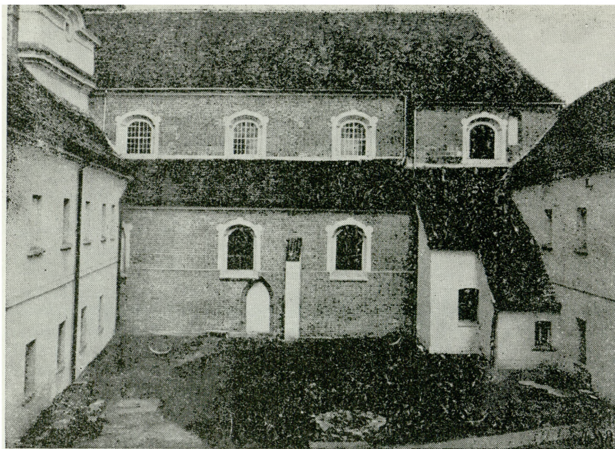
6. Mogilno, elewacja południowa kościoła klasztoru benedyktynów. Widoczne trafne podkreślenie fragmentów dawnej architektury, odkrytych w czasie prac konserwatorskich; na pierwszym planie studnia średniowieczna, odkryta w czasie prac wykopaliskowych (fot. A. Ciechanowski)
