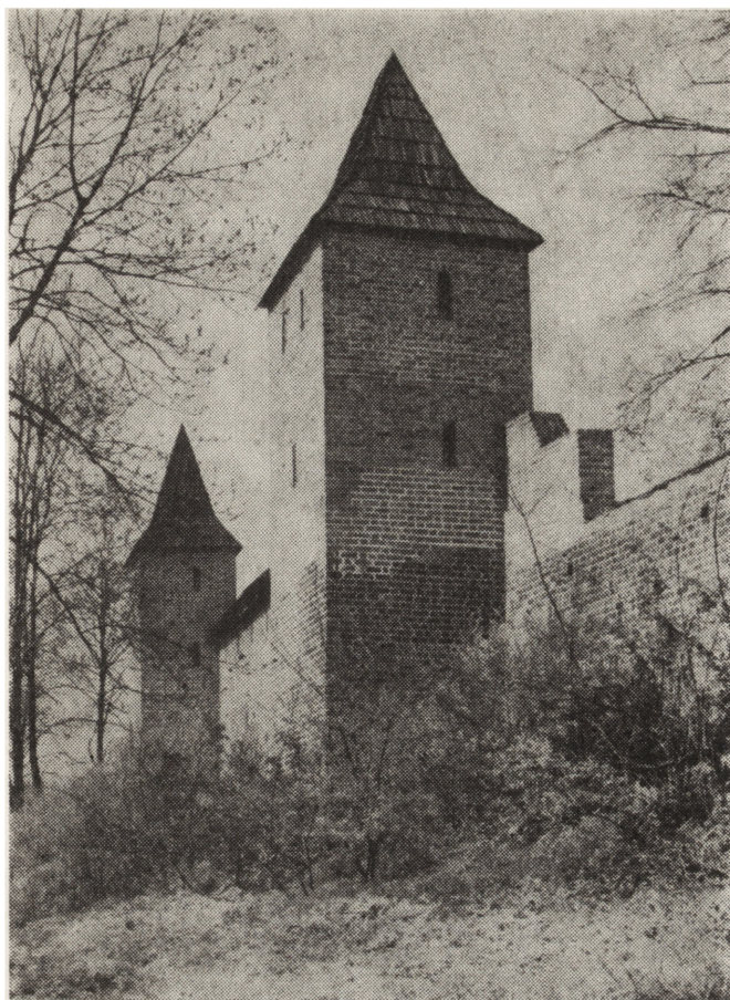
12. Środa Śląska, fragment murów obronnych po konserwacji i rekonstrukcji górnych partii i dwóch baszt (fot. J. Milka)
