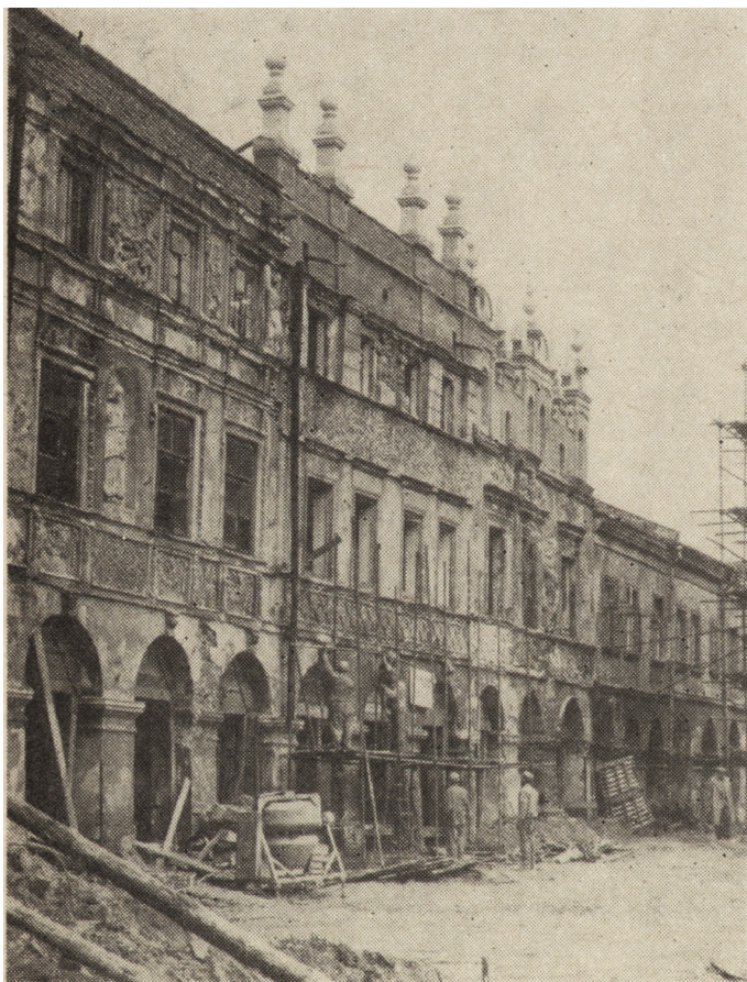
1. Zamość, stawianie rusztowań do prac konserwatorskich w pierzei południowej rynku
