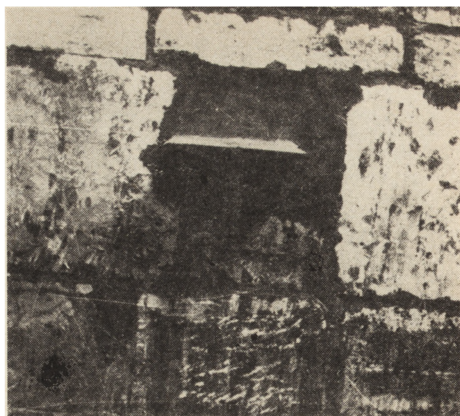
15. Wspornik stalowy osadzony w ścianie Kolegiaty Wiślickiej dla oparcia konstrukcji stropu
