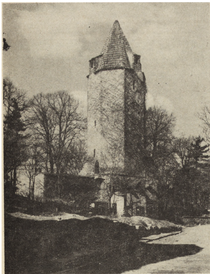
8. Strzegom (woj. wałbrzyskie), odcinek kamiennych murów obronnych z Basztą Dziobową — przykład zabezpieczenia korony dwuspadowym daszkiem ceglany o małym spadku
