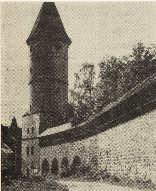
1. Lwówek Śl. (woj. jeleniogórskie), odcinek kamiennych murów obronnych z wieżą Bramy Lubańskiej — przykład rekonstrukcji pełnej według stanu z XV w.
