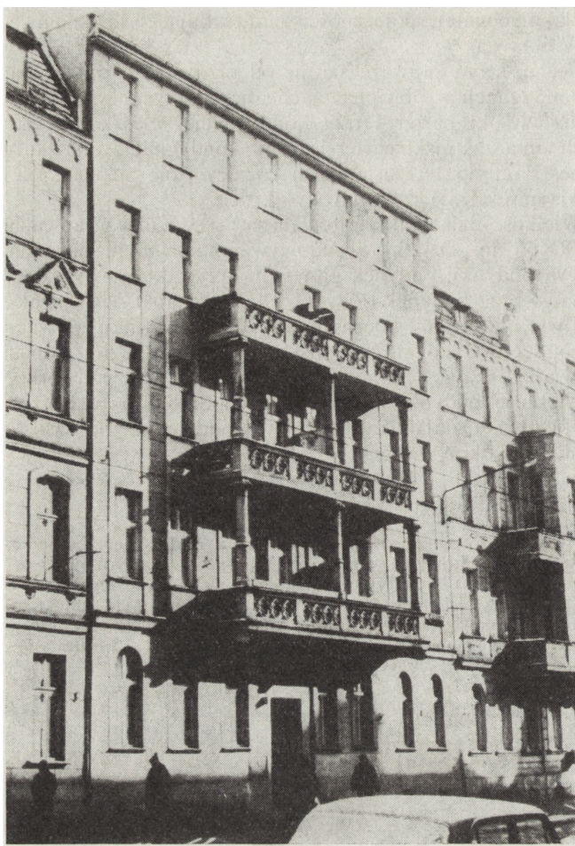
10. Wrocław, ul. Piastowska, kamienica nr 27; w trakcie modernizacji nadbudowano piętro, burząc harmonię całej pierzei (fot. autor)
