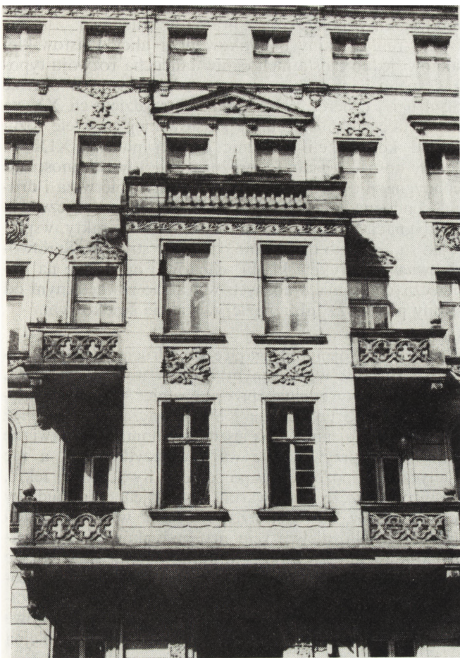
8. Wrocław, ul. Piastowska, fragment elewacji kamienicy nr 34 (fot. autor)
