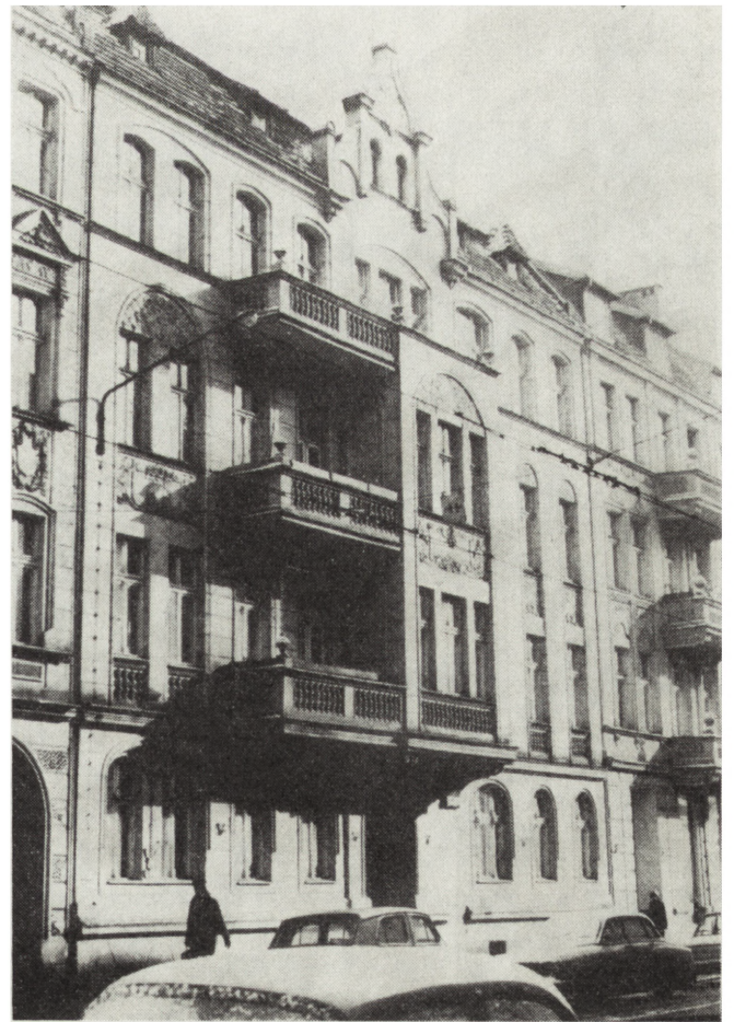
5. Wrocław, ul. Piastowska, kamienica nr 21 (fot. autor)
