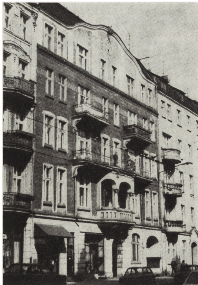
6. Wrocław, ul. Piastowska, kamienica nr 28 (fot. autor)
