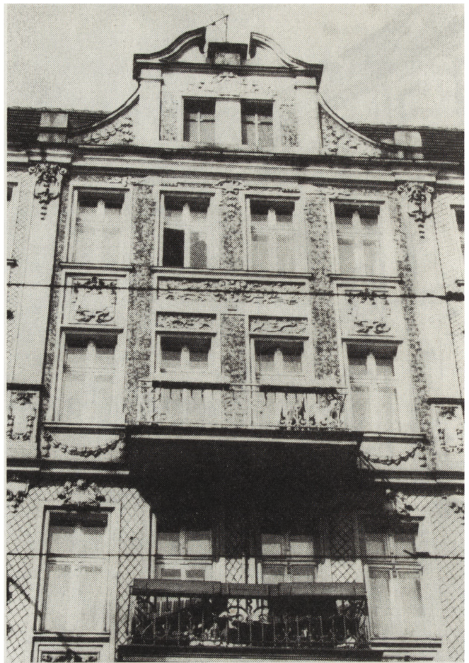
7. Wrocław, ul. Piastowska, fragment elewacji kamienicy nr 26 (fot. autor)
