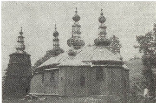
1. Turzańsk, cerkiew w trakcie remontu (fot. Z. Gil, 1981 r.)
