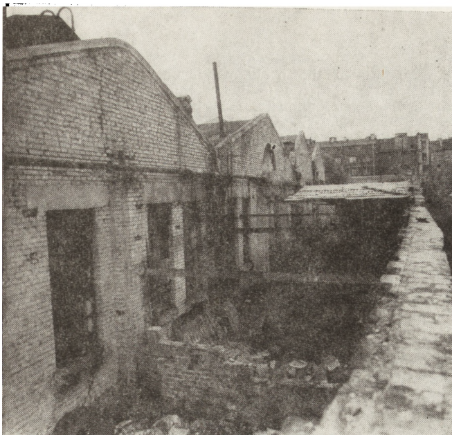
16—18. Fabryka Norblina w Warszawie, stan z 1981 r., widok budynków fabrycznych i wewnątrz hal produkcyjnych
