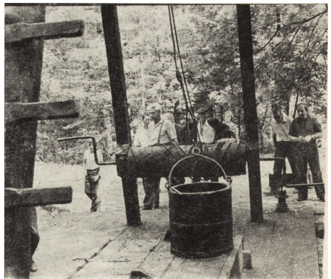
8. Bóbrka, Muzeum Eksploatacji Złóż Ropy Naftowej: a – dziewiętnastowieczne urządzenia wiertnicze; b – fragment szybu „Franek” założonego przez I. Łukasiewicza (fot. CAF)
