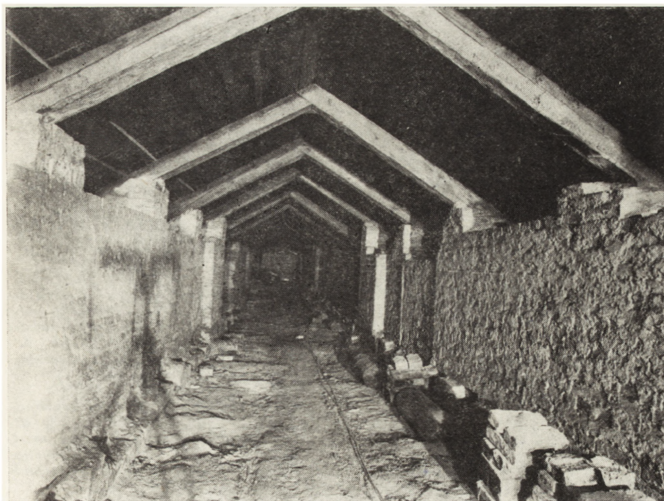
8. 9. Fort Ehrensvärda, budynek flankujący; główny magazyn na pierwszym piętrze (8) oraz korytarz na strychu (9) (fot. Suomenlinnan Hoitokunta)
