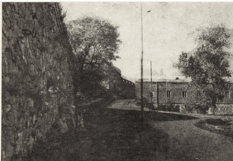
2. Wyspa Susisaari od strony zatoki Tykistolahti, podejście do fortu centralnego (fot. W. Szczerba, 1983)
