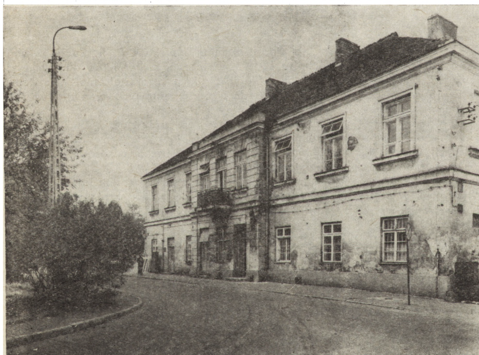
3. Budynek austerii, widok ogólny od strony Al. Krakowskiej, stan w 1984 r.
