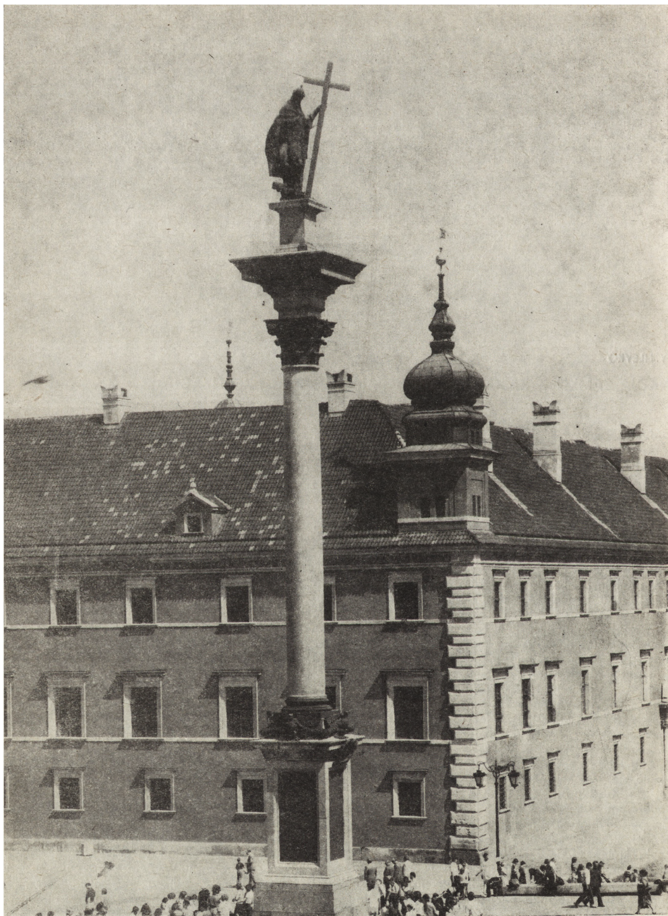
1. Fragment fasady z wieżyczką narożną – stan po 1980 r. (fot. J. Szandomirski)
