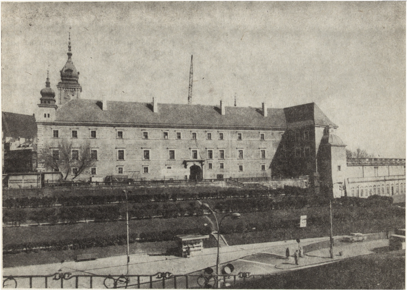
2. Elewacja południowa z Wieżą Grodzką – stan po 1980 r. (fot. A. Wawrzonowski)
