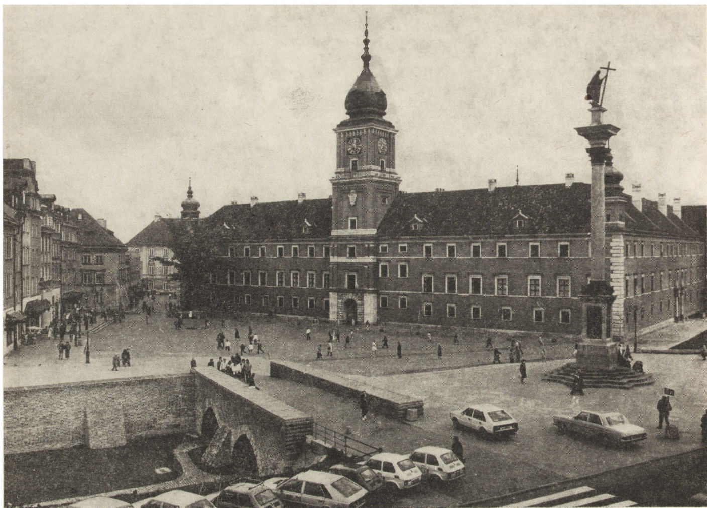
12. Zamek Królewski po odbudowie (fot. Z. Dubiel)
