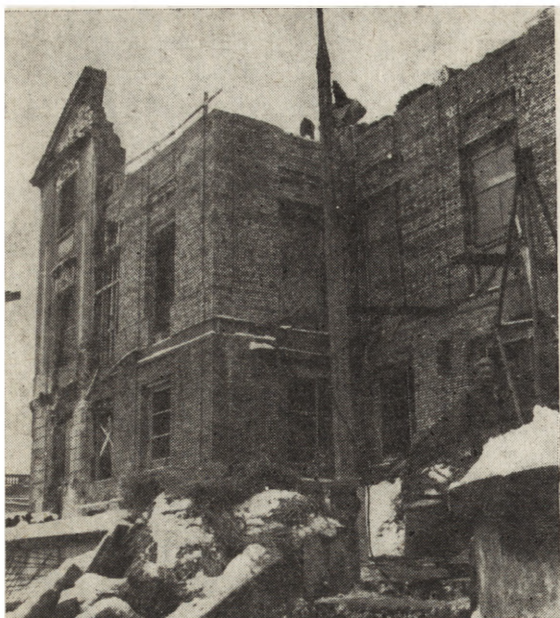
7. Skrzydło saskie, ryzalit lewy. Na zdjęciu widoczny oryginalny fragment budowli połączony z nowo wznoszoną ścianą – grudzień 1973 r.
