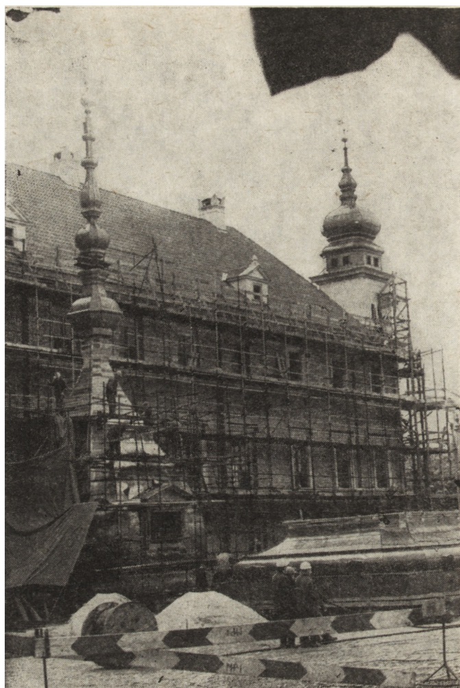
13. Ukończony całkowicie helm Wieży Zegarowej czeka na podniesienie dźwigiem. Obok budynku widać wyższą część, a z prawej dolną część helmu. Mały helm narożny został już zamontowany (fot. A. Pulikowski)
