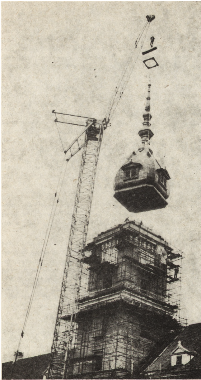
15. Moment montażu helmu narożnego na murach skrzydła zachodniego
