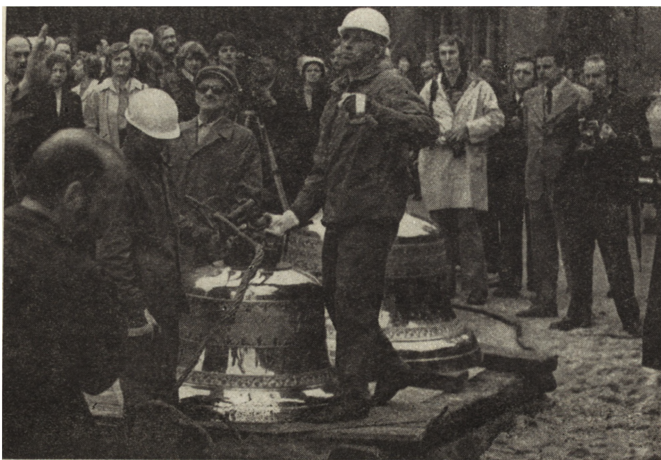
14. Dzwony gotowe do przeniesienia dźwigiem na przygotowane łóża wewnątrz konstrukcji helmu Wieży Zegarowej. Pośrodku (w okularach) stoi twórca dzwonów ludwisarz, Antoni Kruszewski (fot. A. Pulikowski)
