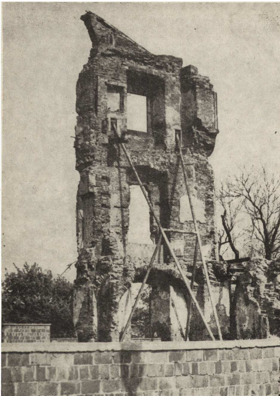
1. Zachowany w pełnej wysokości lewy ryzalit skrzydła saskiego zabezpieczony przed zniszczeniem specjalną konstrukcją z rur stalowych (fot. A. Lubicz-Lisowski)
