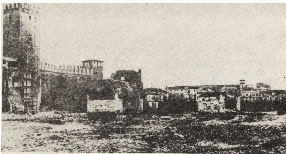
14. Werona, most Castelvecchio po zniszczeniu
