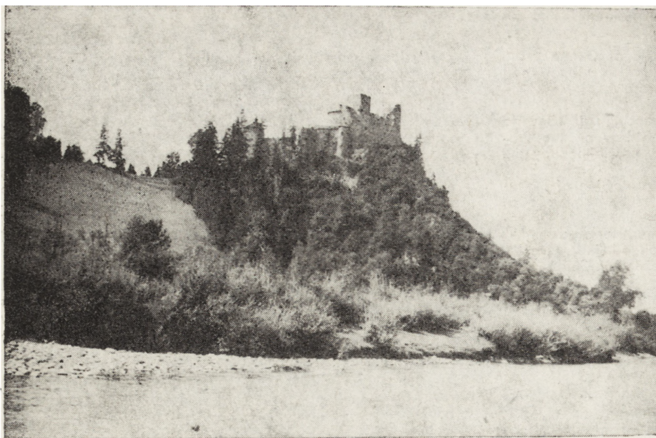
1. Widok na zamek w Niedzicy od strony Dunajca, 1957 r.
