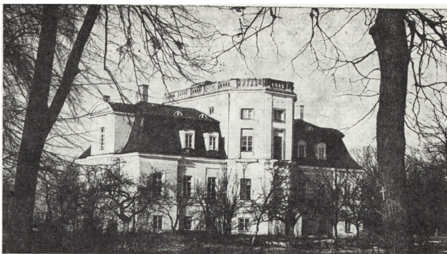
4. Łabunie, pałac, elewacja ogrodowa – stan po konserwacji, 1985 r.
