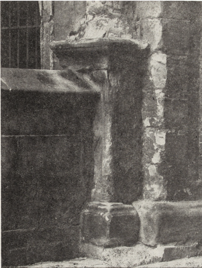
3. Fragment dolnej części portalu Berrecciego z lewej strony – stan przed konserwacją. Widoczne ubytki kamienia i jego destrukcja w partii bazy kolumny, czerwiec 1985 r.
