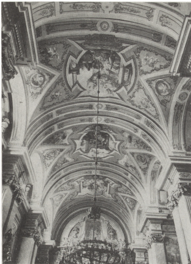
25. Sklepienie nawy głównej po konserwacji (fot. A. Stasiak) 25. Vaulting of nave following conservation
