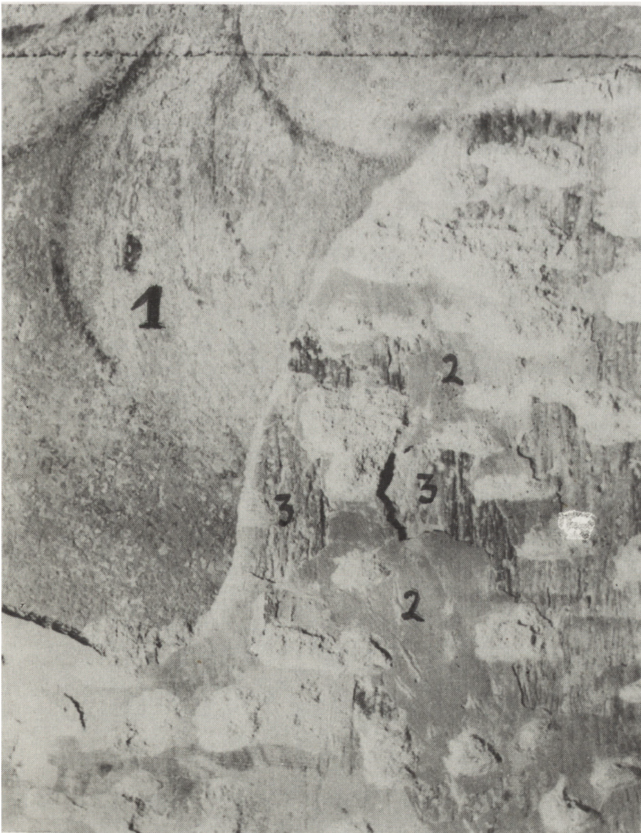
5. Rozwarstwienie tynków na północnej ścianie nawy głównej: 1 — tynk z polichromią W. Żebrowskiego; 2 — tynk z polichromią z lat 1663–1667; 3 — tynk z polichromią z lat 1670–1677 (fot. K. Tiunin)
