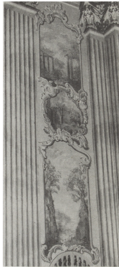
26. Fragment północnej ściany nawy głównej po konserwacji (fot. J. Szandomirski) 26. Fragment of northern wall of nave following conservation
