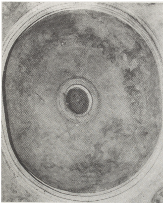
17. Sklepienie kaplicy bł. Ładysława — konserwacja z lat 1947–1953 (fot. J. Szandomirski)
