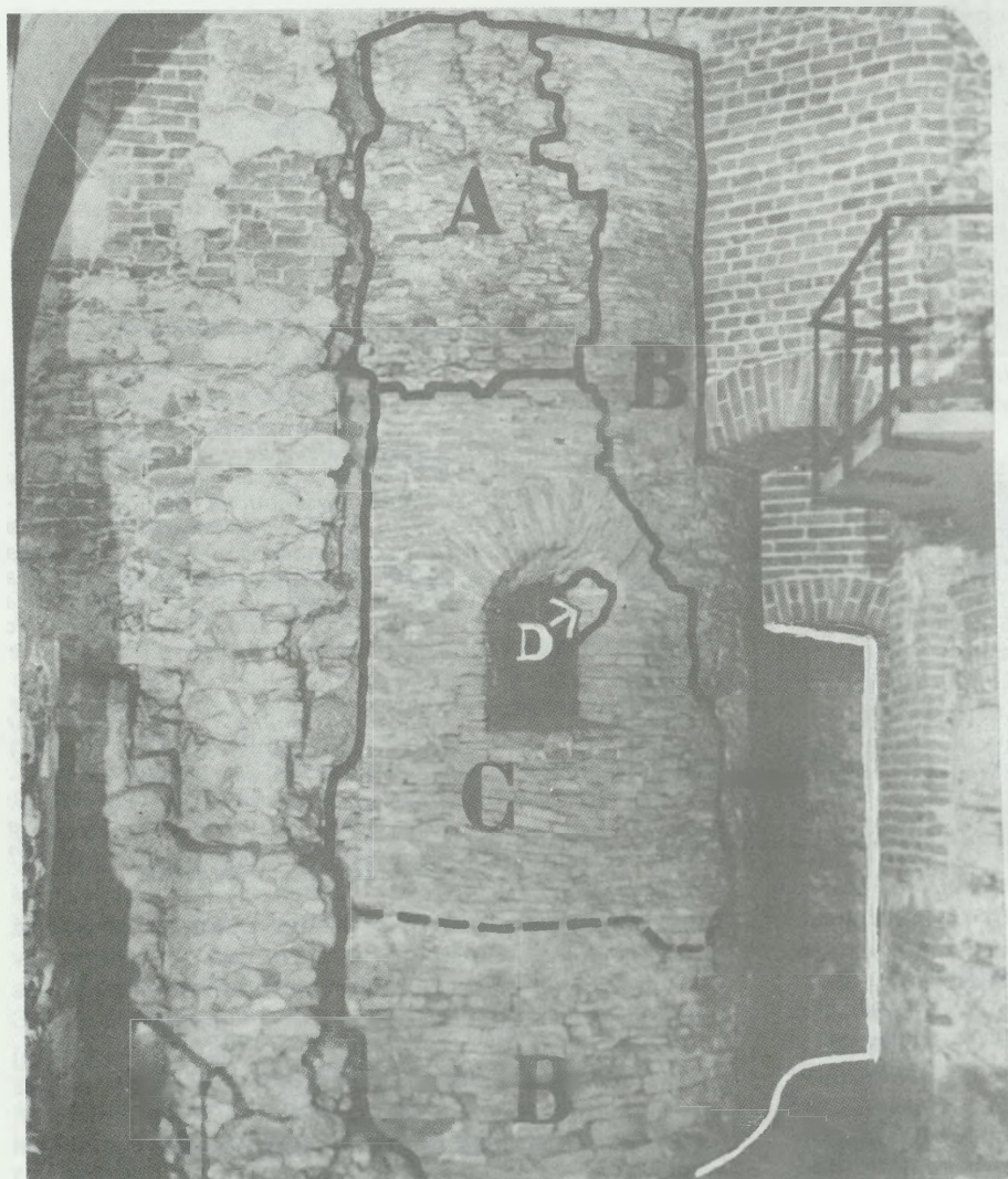
6. Zewnętrzne lico absydy południowo-wschodniej, stan po konserwacji: A – wątek przedromański, lico nie zachowane, B – wątek przedromański, z zachowanym licem i drobnymi naprawami późniejszymi, C – lico rekonstruowane przez A. Szyszko-Bohusza, D – oryginalny fragment glisty okienka. Fot. K. Musiał oprac. autora
