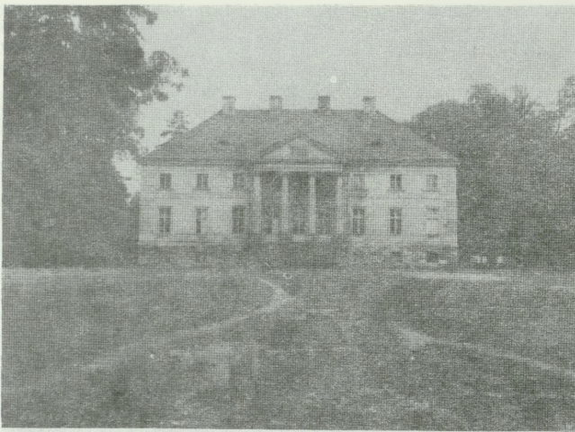
11. Sierniki — gm. Rogoźno. Pałac przed przystąpieniem do remontu (fot. W. Beszterda)
