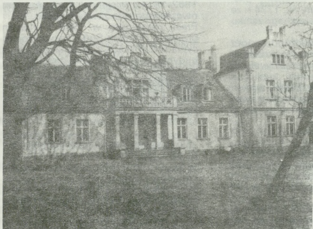
1. Bagdad — gm. Wyrzysk. Dwór przed rozpoczęciem prac konserwatorskich (fot. W. Beszterda)
