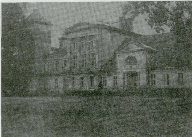
5. Jabłonowo — gm. Ujście. Pałac i dwór przed remontem (fot. W.Beszterda)
