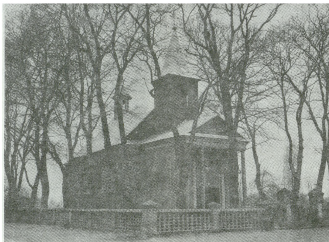
19. Czarne w Ziemi Dobrzyńskiej, 1793, kościół klasycystyczny z portykiem kolumnowym w wielkim porządku
