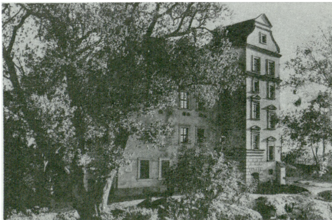
7. Płoty – Zamek Stary, XIII w., przebudowany 1540 i 1577 (fot. G. Solecki, 1968)
