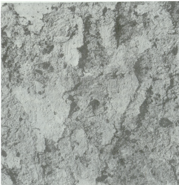
6. Makrofotografia lica sgraffita podczas doczyszczania. Widoczna kruchość zaprawy
