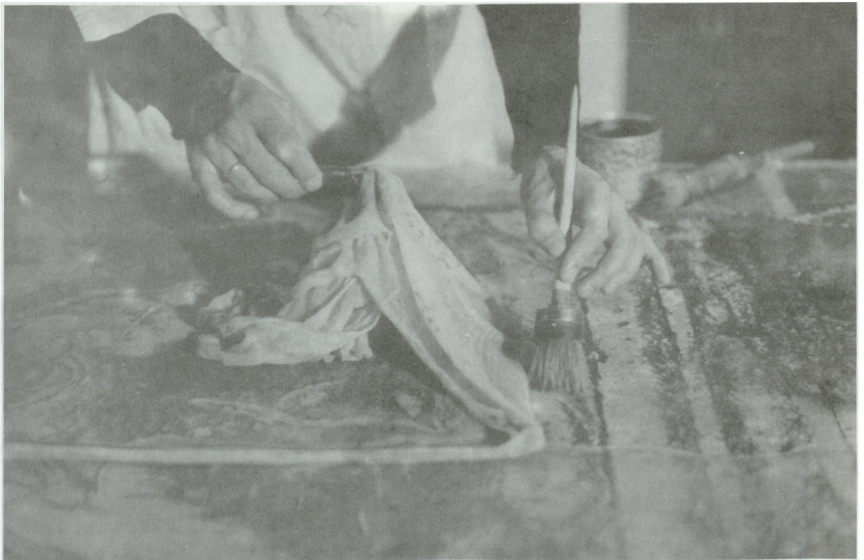
12. Chojnów, Muzeum Regionalne – usuwanie zabezpieczenia z lica sgraffita 12. Chojnów, the Regional Museum – removing the protection layer from the face of the sgraffito
