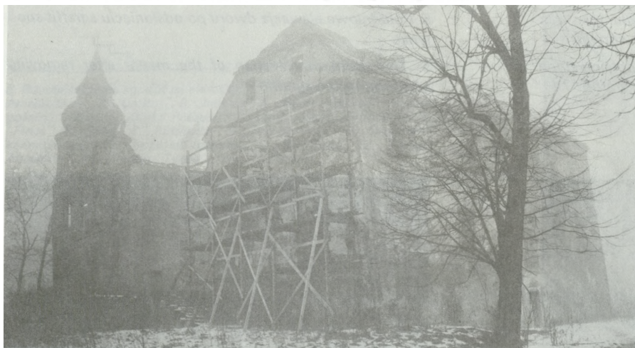
1. Zagrodno, dwór, stan zachowania podczas prac konserwatorskich – (widok z południowego wschodu)
