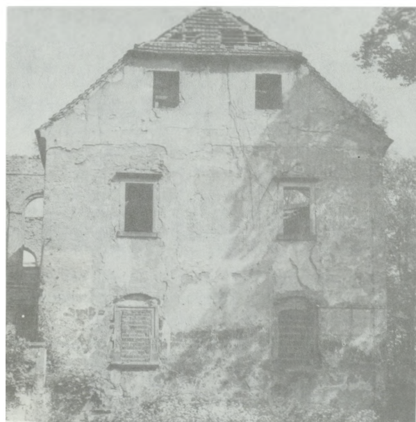
2. Zagrodno, dwór – południowa elewacja wschodniego skrzydła przed odsłonięciem sgraffit spod tynku (wszystkie fot. M.Stec)
