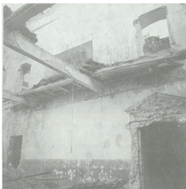
3. Fragment zachodniej ściany wschodniego skrzydła dworu (obecnie wewnętrznej) z zakrytymi tynkiem sgraffitami
