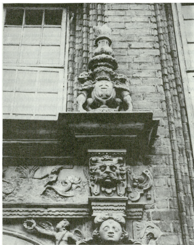
5C. Fragment belkowania i gzymsu portalu Sieni Gdańskiej – po konserwacji
