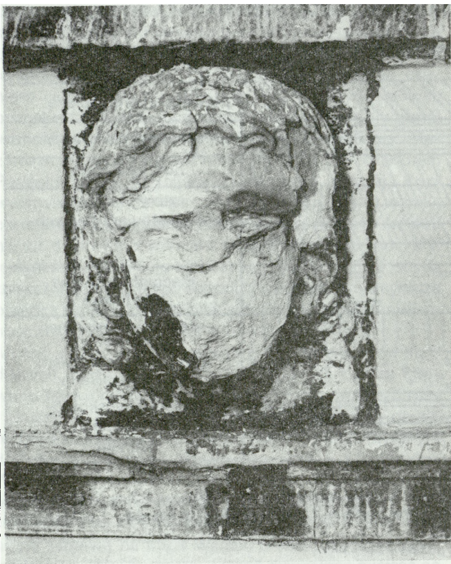
7A. Fasada kamienicy przy ul. Piwnej 1 w Gdańsku. Rzeźba przed konserwacją 7A. The facade of the house at 1 Piwna Street in Gdańsk. A sculpture before conservation.
