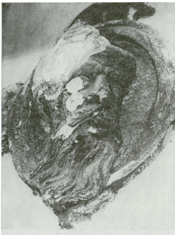
11. Fasada kamienicy przy ul. Piwnej 1 w Gdańsku. Rzeźba przed konserwacją 11. The facade of the house at 1 Piwna Street in Gdańsk. A sculpture before conservation.
