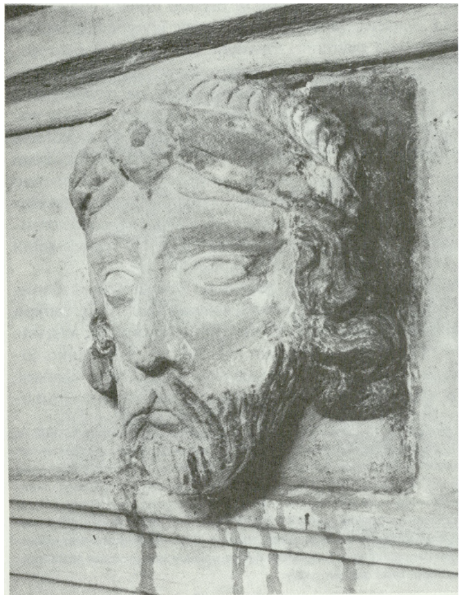
9B. Fasada kamienicy przy ul. Piwnej 1 w Gdańsku. Rzeźba w trakcie konserwacji 9B. The facade of the house at 1 Piwna Street in Gdańsk. A sculpture during conservation.
